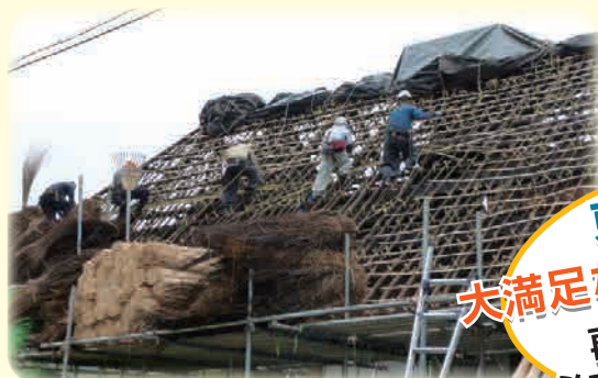
↑茅葺き屋根の葺き替え中。 めったに見られないところに遭遇しました！
